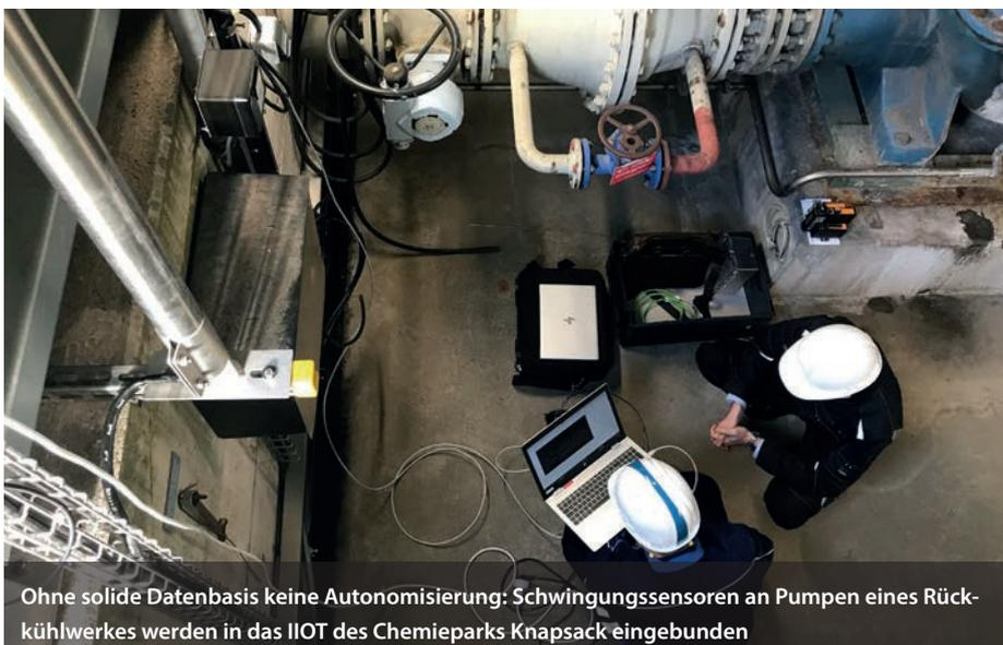
Ohne solide Datenbasis keine Autonomisierung: Schwingungssensoren an Pumpen eines Rückkühlwerkes werden in das IIOT des Chemieparks Knapsack eingebunden
