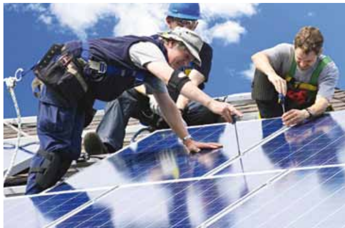
Ein Dachdecker sammelt Erfahrungen mit Materialien, allerdings fehlt eine Schnittstelle, über die er diese Erkenntnisse kommunizieren könnte
