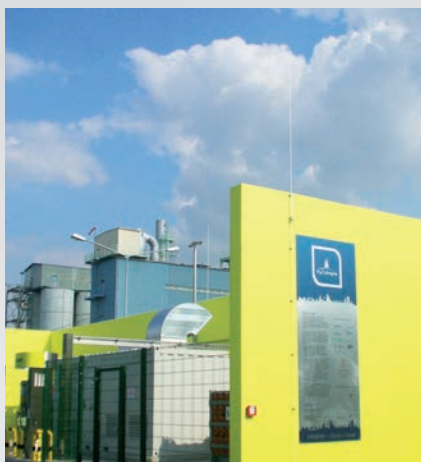
Wasserstoff-Tankstelle am Chemiepark Knapsack in Hürth – Quelle: HyCologne e.V.
