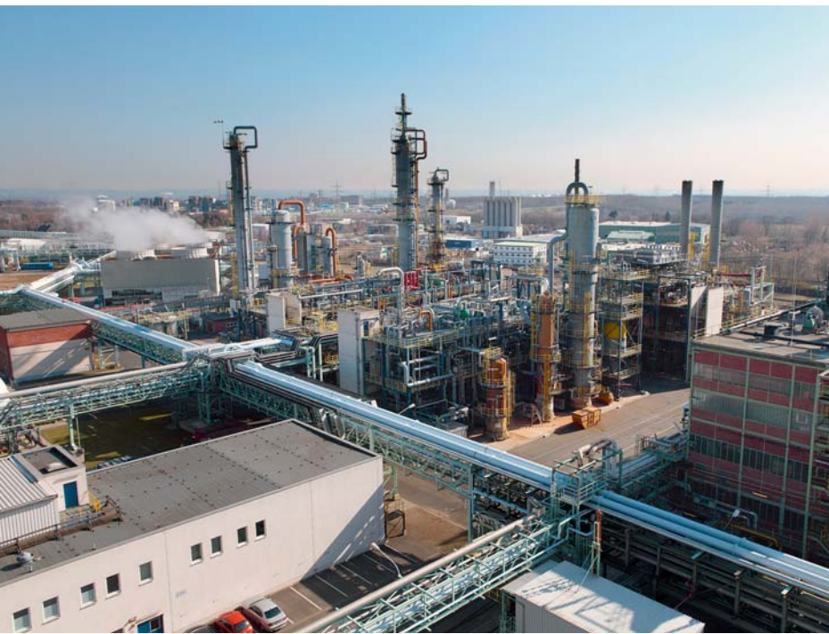
Industrie-Ästhetik: Chemiepark Hürth-Knapsack. Im Bild unter anderem zu sehen: die Vinylchlorid-Anlage des Unternehmens Vinnolit GmbH & Co. KG.
